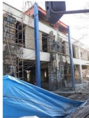
پروژه بیمارستان چمران بتن ریزی بخشی از دیوار برشی
