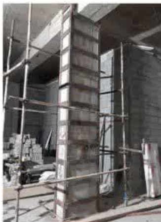
ژاکت فلزی تقویت ستون
