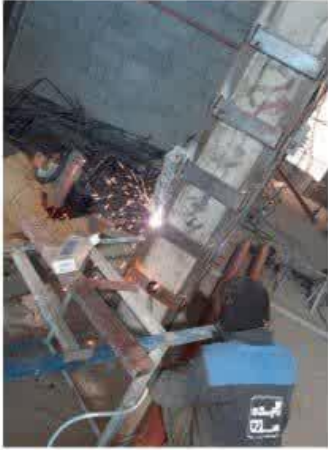
ژاکت فلزی تقویت باربری ستون
