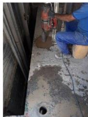
فناوری IT اداری پردیس کرگیری محل عبور وال هنگ و کفشور
