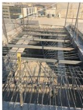
پارک فناوری پردیس عملیات تقویت تیر بتنی و کاشت جهت ایجاد پوشش بتنی آرماتور محل بازشو در کف بام
