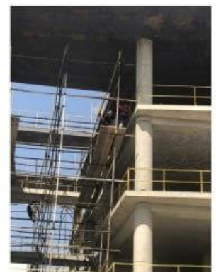
پارک فناوری پردیس سوراختاری جهت اضافه نمودن مقاطع زیرسازی نما
