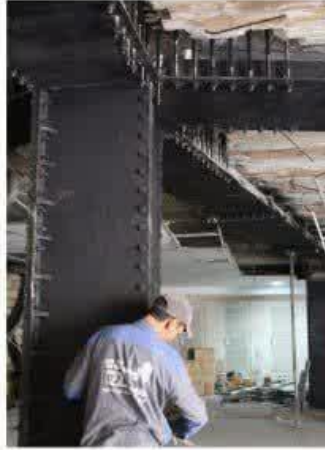
ژاکت فلزی تقویت تیر و ستون
