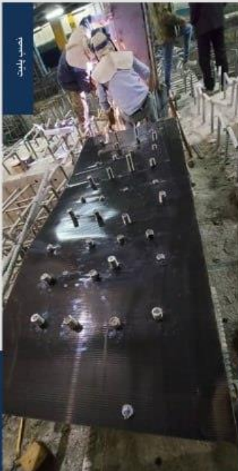
سوراخ کاری و کاشت انواع بولت و نصب پلیت
