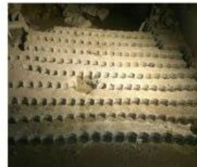
کرگیری چاله آسانسور پروژه مسکونی ۹۰۰ واحدی قزوین
