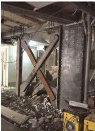
ایجاد دیوار برشی فلزی
