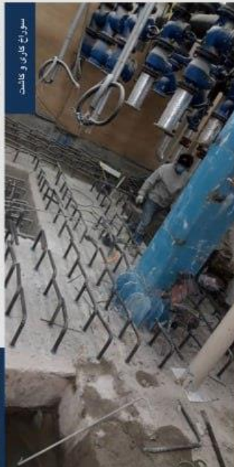
سوراخ کاری و کاشت انواع بولت و نصب پلیت
