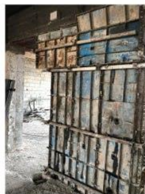
پروژه بیمارستان چمران تقویت جهت قالب بندی دیوارهای برشی آماده سازی برای بتن ریزی ۲
