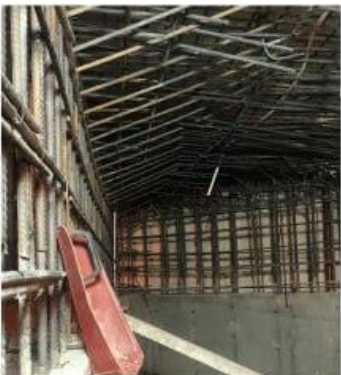
پروژه برج الهیه مراحل پایانی آرماتوربندی معکوس سقف و آماده سازی جهت قالب بندی
