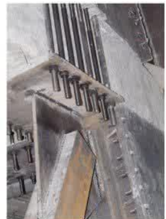
ژاکت فلزی تقویت تکیه گاه
