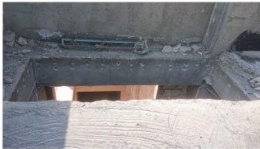
کلاک ایده سوراخ کاری جهت ایجاد سقف در ویدها
