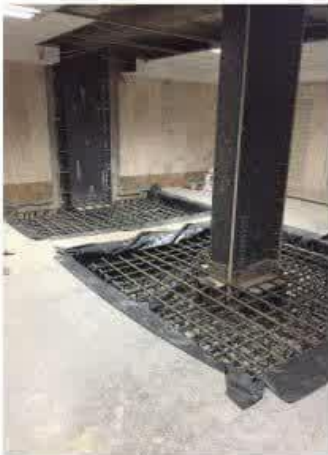
ژاکت فلزی و تقویت فونداسیون
