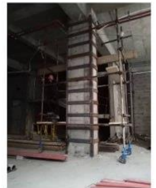
پروژه مسکونی الهیه اجرای ژاکت فلزی ۱۲۲۳
