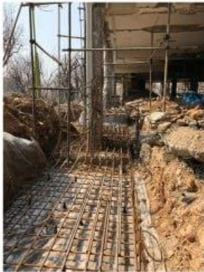
آرماتوربندی فونداسیون تقویت ضلع جنوب شرقی پروژه بیمارستان چمران
