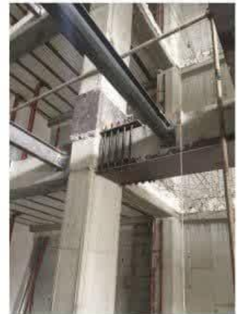
ژاکت فلزی تقویت تیر بتنی
