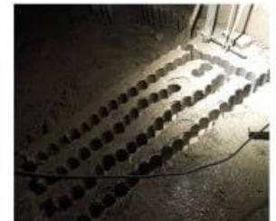
عملیات کرگیری جهت افزایش فونداسیون آسانسور
