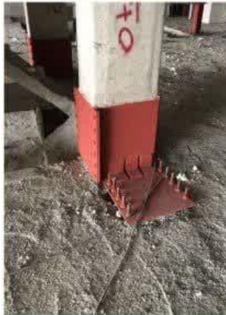
ژاکت فلزی تقویت تکیه گاه
